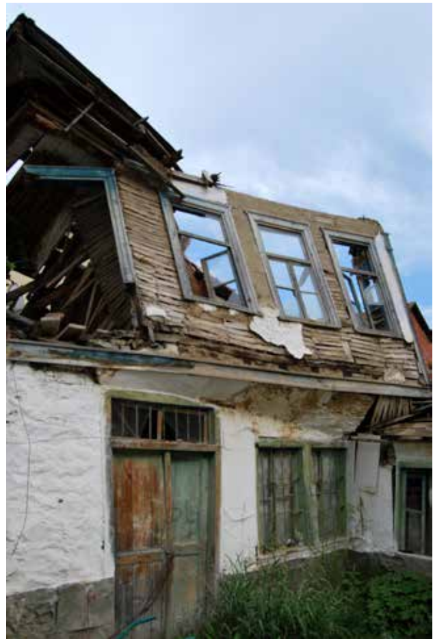
8. Гора, село Брод, Шољино маало, детаљ урушене конструкције старе куће
